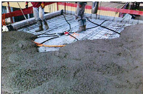
d'épaisseur. L'isolation extérieure est faite de plaques de polystyrène et de laine de roche : les murs exposés au nord sont isolés à la laine de roche, ceux au sud isolés par du polystyrène. Ensuite, la dalle de rez-de-chaussée est ferrillée, on y place tous les réseaux de chauffage, d'eau chaude, froide et sanitaire pour les calorifuger et les
